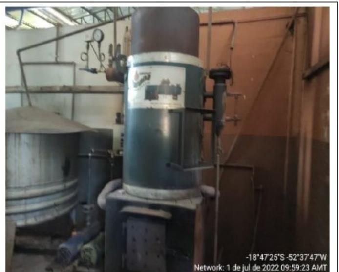
Figura 2: Imagem do FUMEGADOR, equipamento utilizada para redução da emissão de poluição atmosférica (fuligem).
