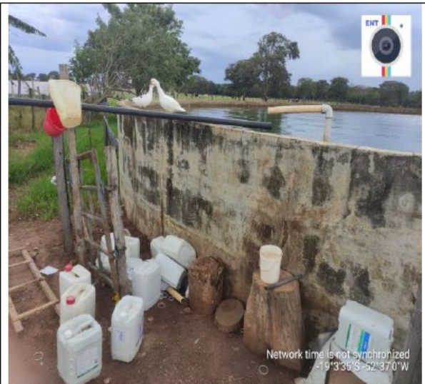
Figura 2: Verifica-se na ocasião, as únicas embalagens que estavam sendo manuseadas.
