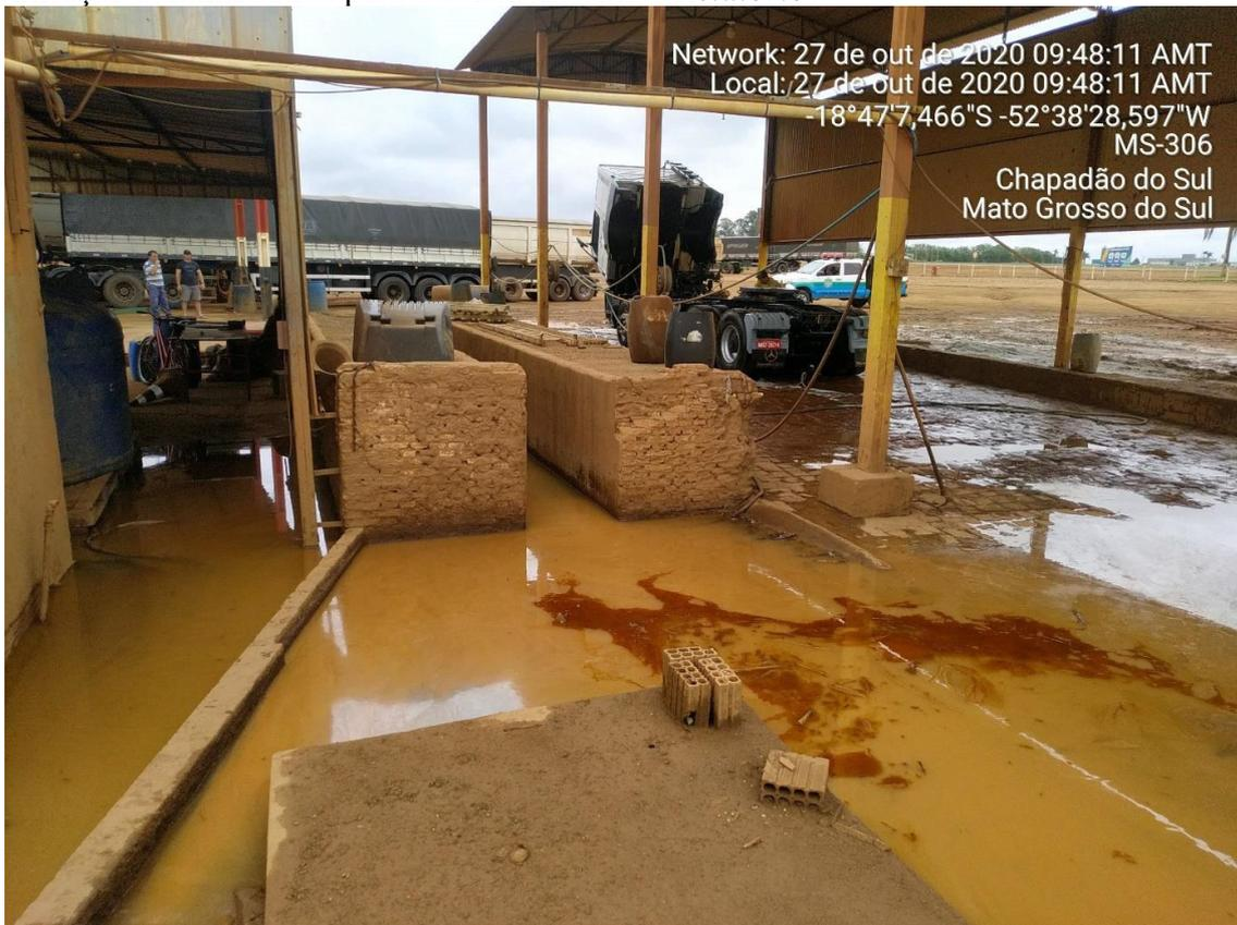
**Figura1: Resíduos do lavador fora da caixa separadora.**
